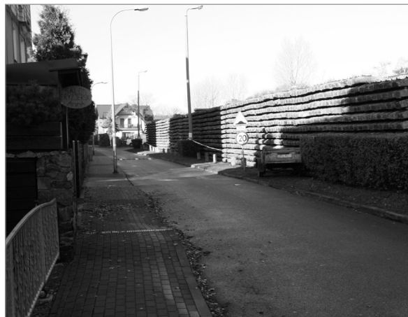
Zużyte podkłady kolejowe zostaną wykorzystane na terenie budowy jako kruszywo
