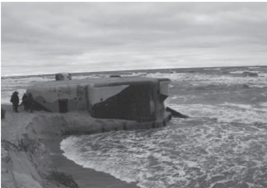
Rejon bunkrów pod Jastarnią to jedno z miejsc refulacji
