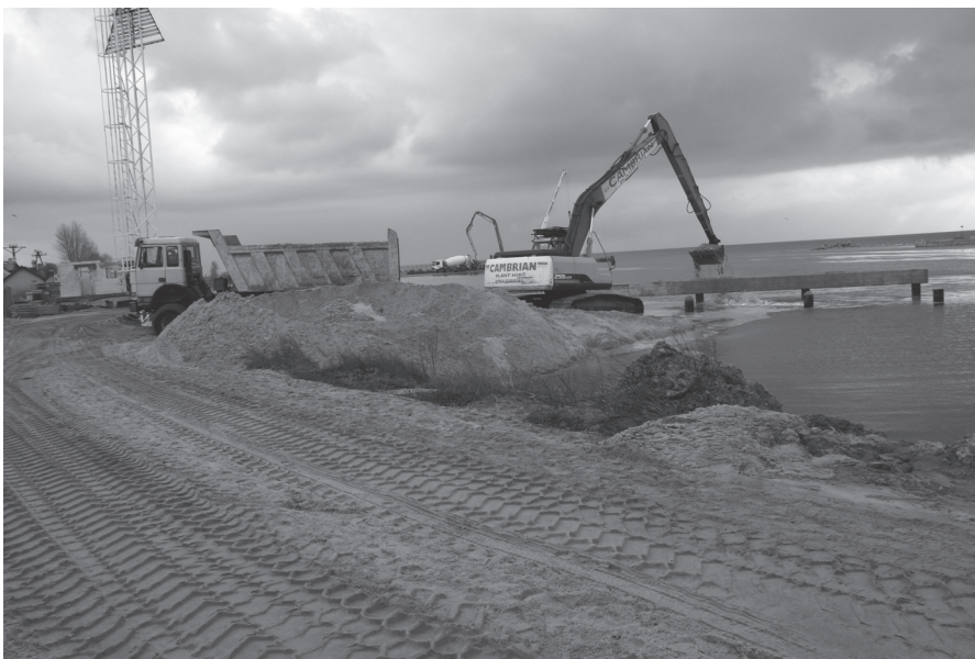
W lecie przyszłego roku port w Kuźnicy ma być gotowy
