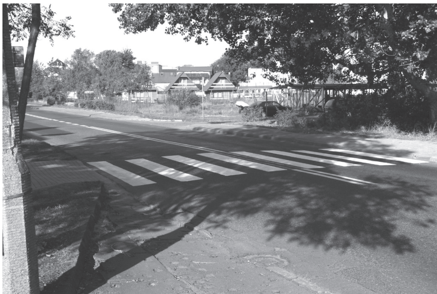
Przejście przez ulicę Mickiewicza w tym miejscu było niezbędne
