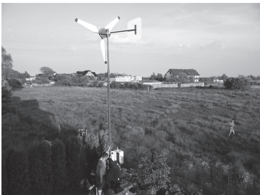
Postawienie elektrowni trwa niespełna godzinę
